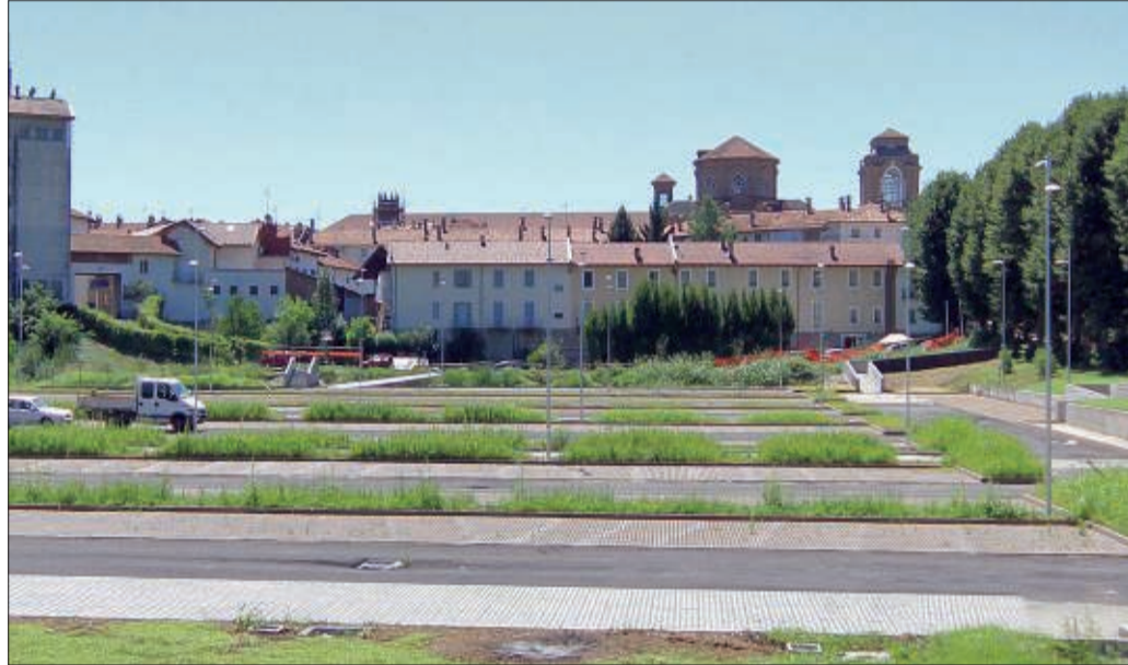
I parcheggi che sono stati realizzati lungo le rive del torrente Ceronda, a due passi dal complesso sabauda
